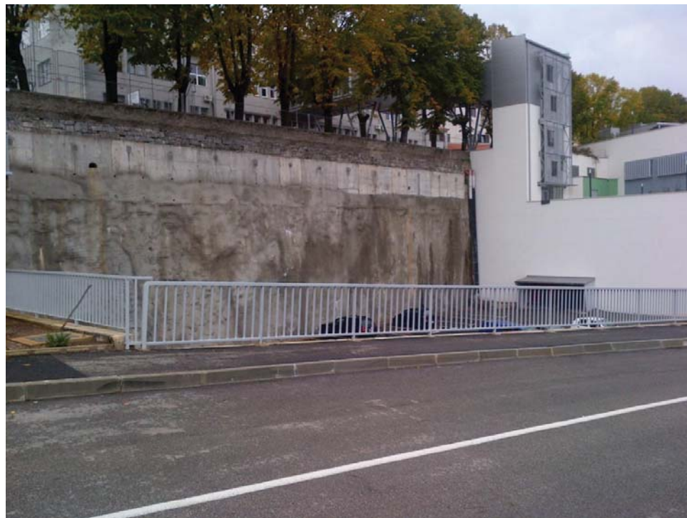
Pogled s juga na parcelu na kojoj je planirana izgradnja zgrade Multimedijalnog centra
