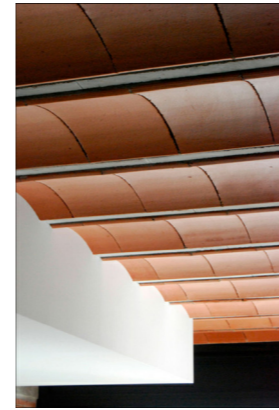
PRIMJER GLINENIH ELEMENATA STROPA KAO IZGUBLJENE OPLATE
