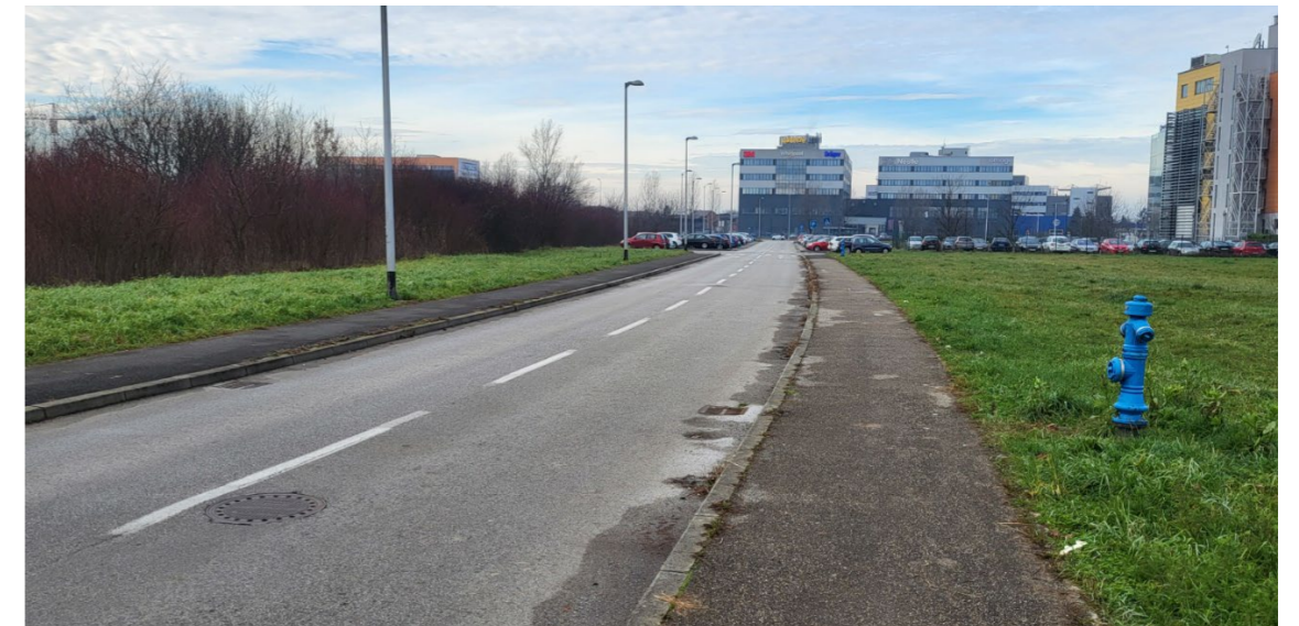
slika 5. pogled na Ul. Milutina Milankovića (prema istoku): postojeće stanje određenih instalacija uvidom na terenu
